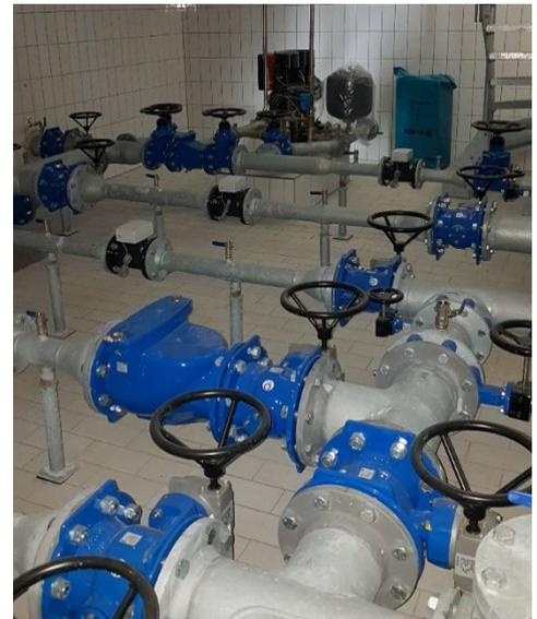
*Vor der Modellierung des Geländes wurde die Außenwand gedämmt und die Trinkwasserleitungen vorverlegt, während im Inneren des Behälters die Hydraulik und Verrohrung installiert wurde.*
